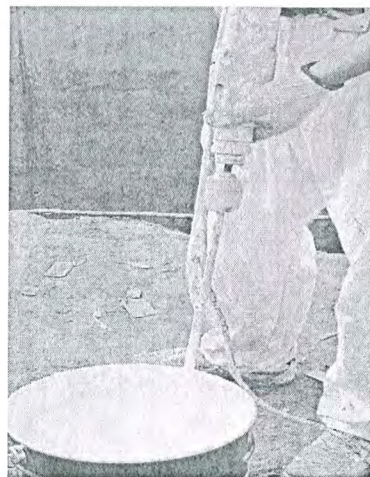
Рисунок 6 – Перемешивание огнезащитного состава
